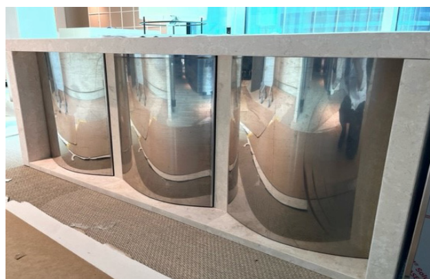
Återbruk av fasadplåt till buffédisk i Platinan. Bild: Sofia Enblom.
