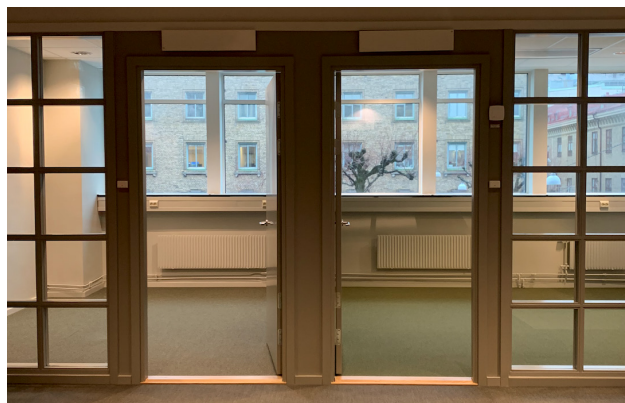
Återbruk av glaspartier i Ströms- huset. Bild: Tove Emanuelsson.
